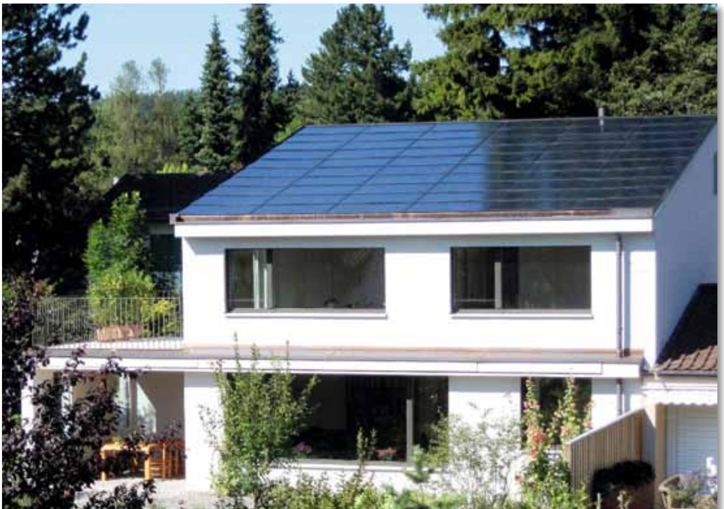
Das Plusenergiehaus in Küsnacht: Energiegewinn durch Südfenster und mit 75 m 2 Photovoltaikdach.
